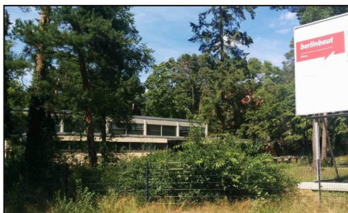
Sporthalle in der Finckensteinallee wird saniert
