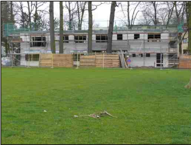
Die hier noch im Bau befindliche Geschäftsstelle in der Krahrmerstraße 15 wird das neue Domizil des TuSLi
